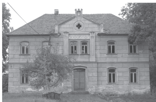
Obr. 3. Školní budova v Bělčí nad Orlicí (okr. Hradec Králové) z roku 1863 byla v letech 1910–11 zvýšena o patro a nadále sloužila jako modlitebna filiálního sboru. Foto autor, stav před rekonstrukcí v letech 2016–17.
