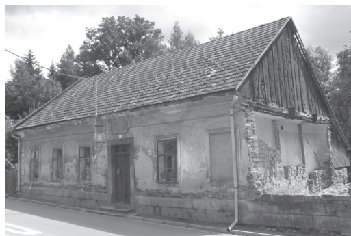
Obr. 2. Evangelická škola v Rusavě (okr. Kroměříž) získala novou budovu v roce 1864. V současnosti jde o jeden z nejzachovalejších objektů svého druhu. Foto autor.
