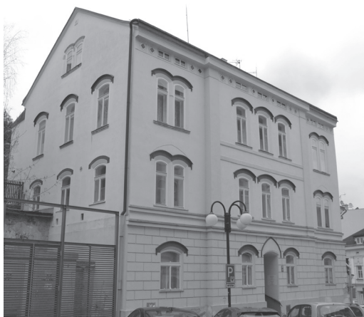
Obr. 5. Rozsáhlá škola německojazyčného evangelického sboru v Jablonci nad Nisou z roku 1903, sloužící zároveň jako fara (vstup z opačné strany). Foto autor.
